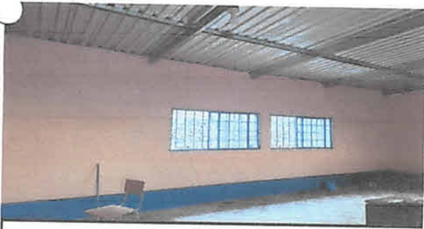
Foto 5: ventanas nuevas y techo
