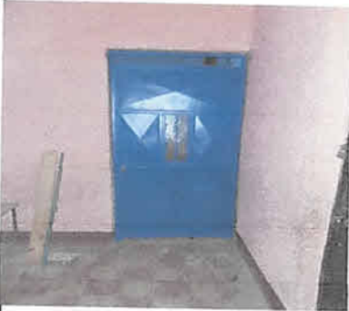
Foto 3: Puerta de bodega
