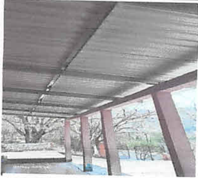
Foto 1: El techo ya cambiado en su totalidad.
