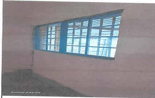
Foto 4: Cambio de ventanas ya instaladas las nuevas
