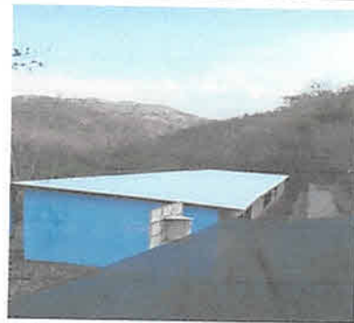
Foto 6: Concluido el remozamiento de techo
